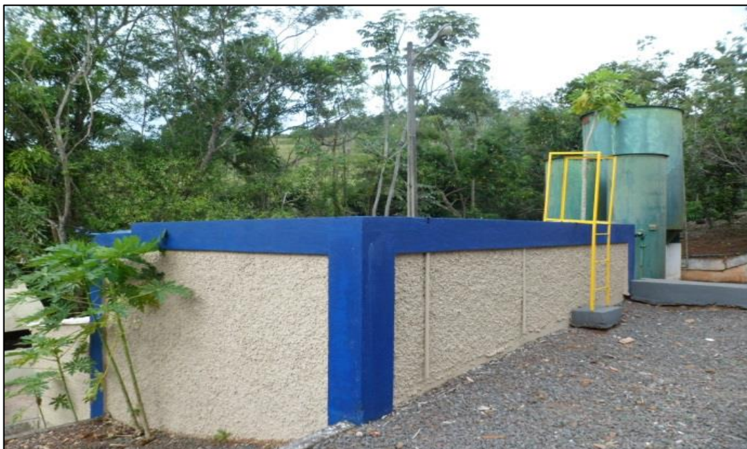
Figura 91: Reservatório do Distrito Alto Alegre do Iguçu.
