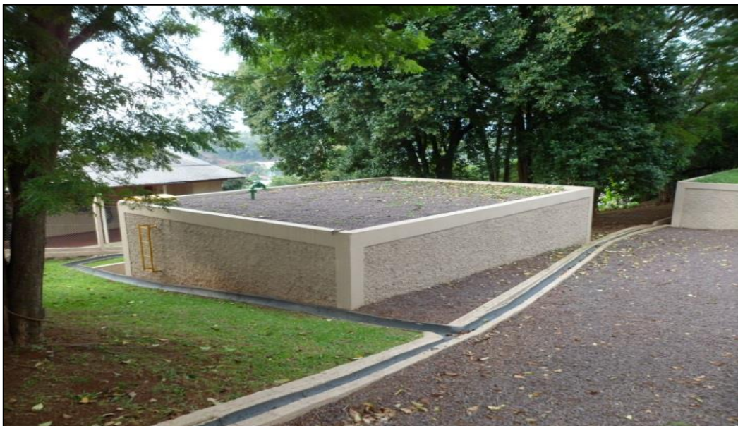
Figura 88: Reservatório Av. Iguaçu,641 - sede urbana.
