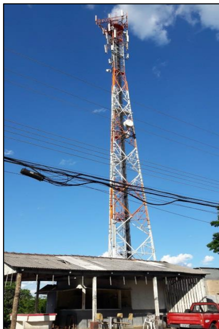
Figura 76: Torre de Telefonia.
