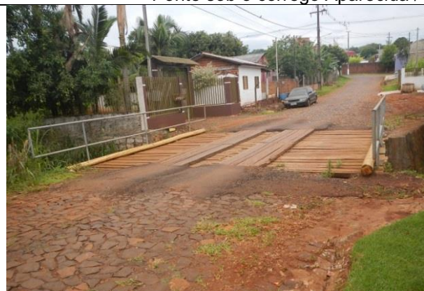
Ponte sob o córrego Aparecida na rua Guarapá
