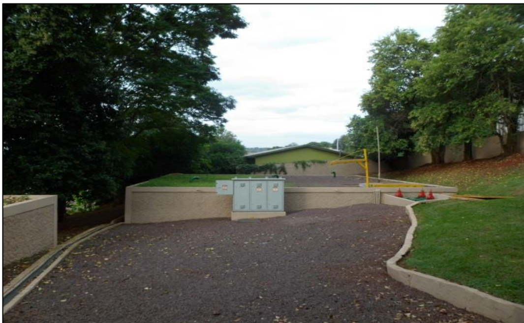
Figura 89: Reservatório Av. Iguaçu, 341.
