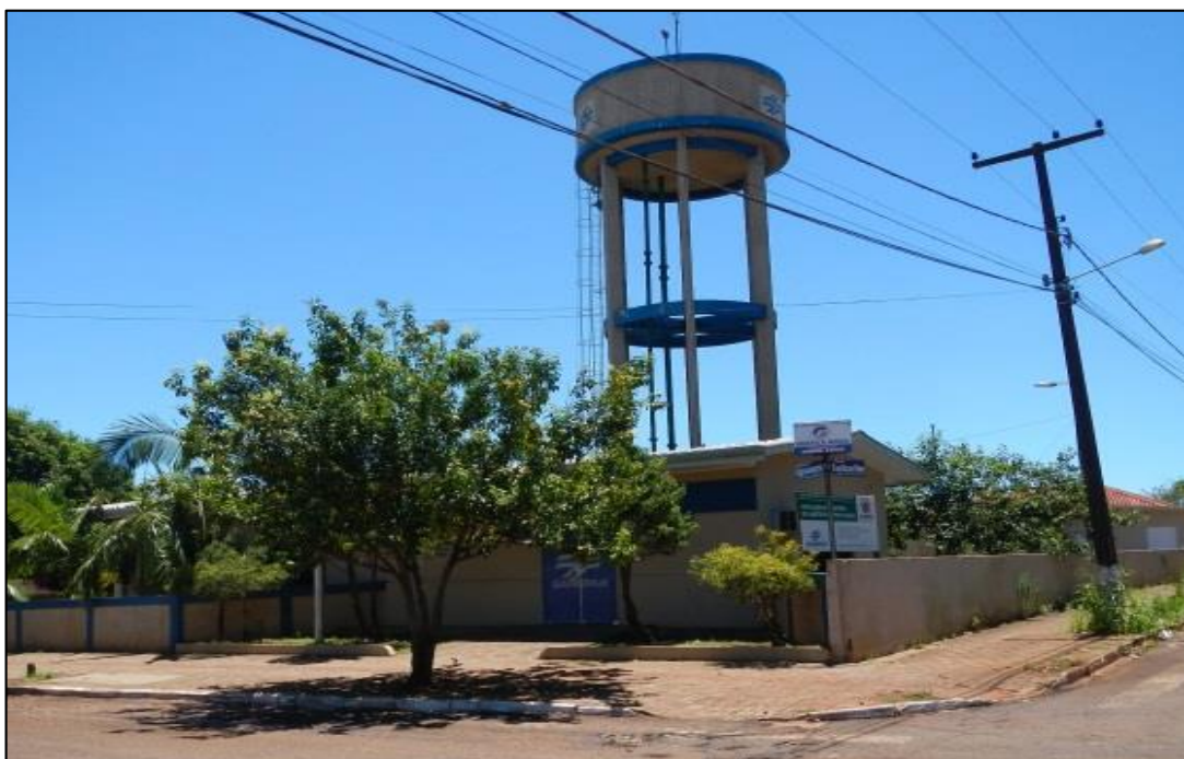
Figura 86: Reservatório Av. Iguaçu 641 sede urbana.
