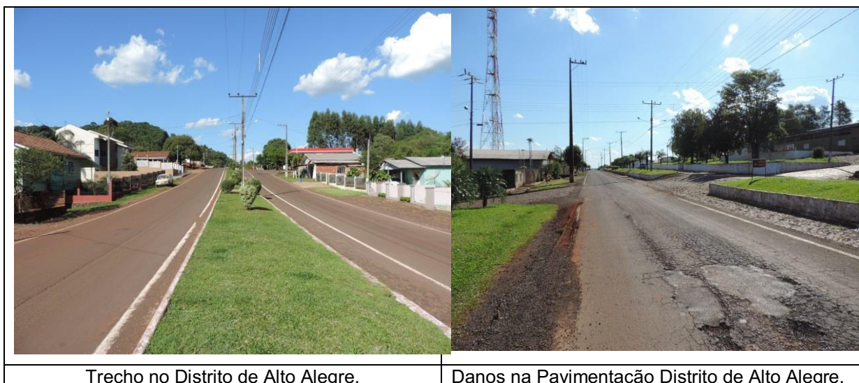
Figura 56: Pavimentação Rodovia Félix Feiwisch Lerner no Distrito de Alto Alegre do Iguaçu.
