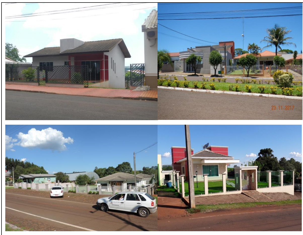
Figura 47: Edificações das áreas mais centrais das sedes urbanas no município de Capitão Leônidas Marques.
