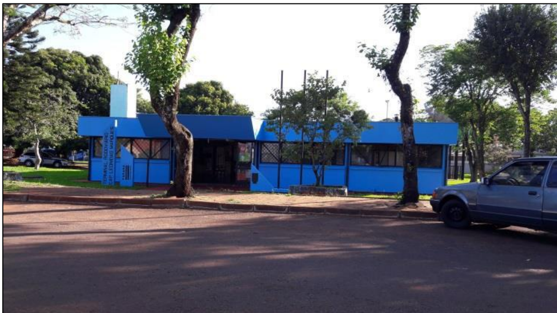
Figura 68: Rodoviária de Capitão Leônidas Marques.
