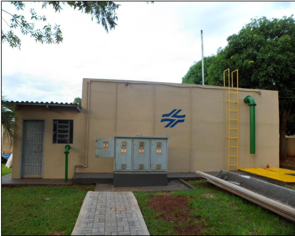
Figura 87: Reservatório Av. Iguaçu, 641 - sede urbana.
