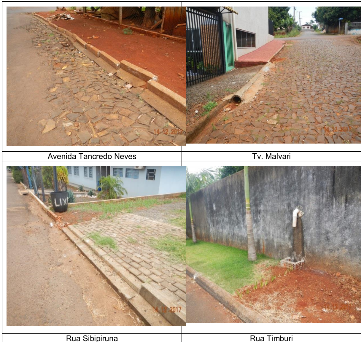
Figura 61: Exemplos de Calçadas da Sede Urbana. Fonte: ECOTÉCNICA, 2017 – Plano Diretor, 2018.
