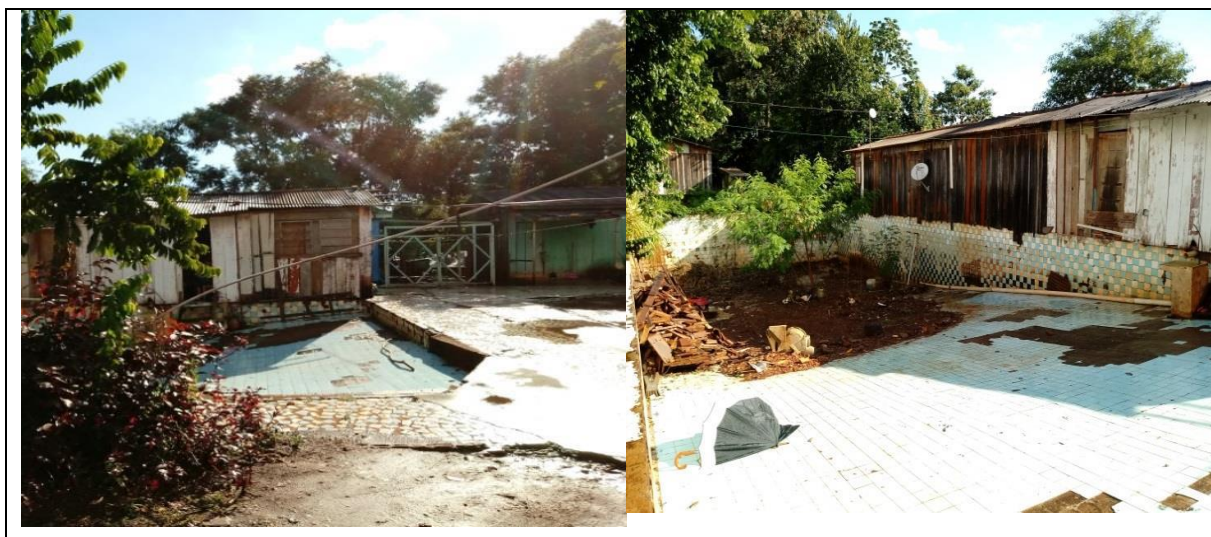
Figura 50: Exemplo de assentamento precário (irregulares) – Piscina Velha.
