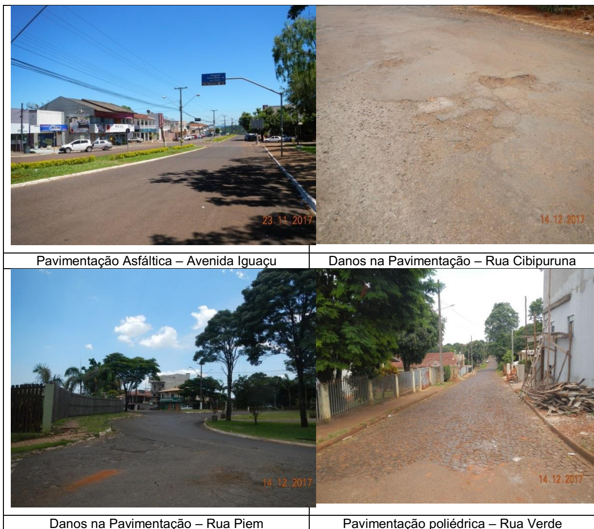
Figura 55: Exemplos de Pavimentação da Sede Urbana.
