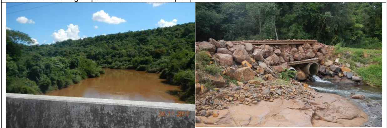
Ponte na PR-484 - sob o rio Andrada – Próximo a Comunidade de Porto 3 irmãos
