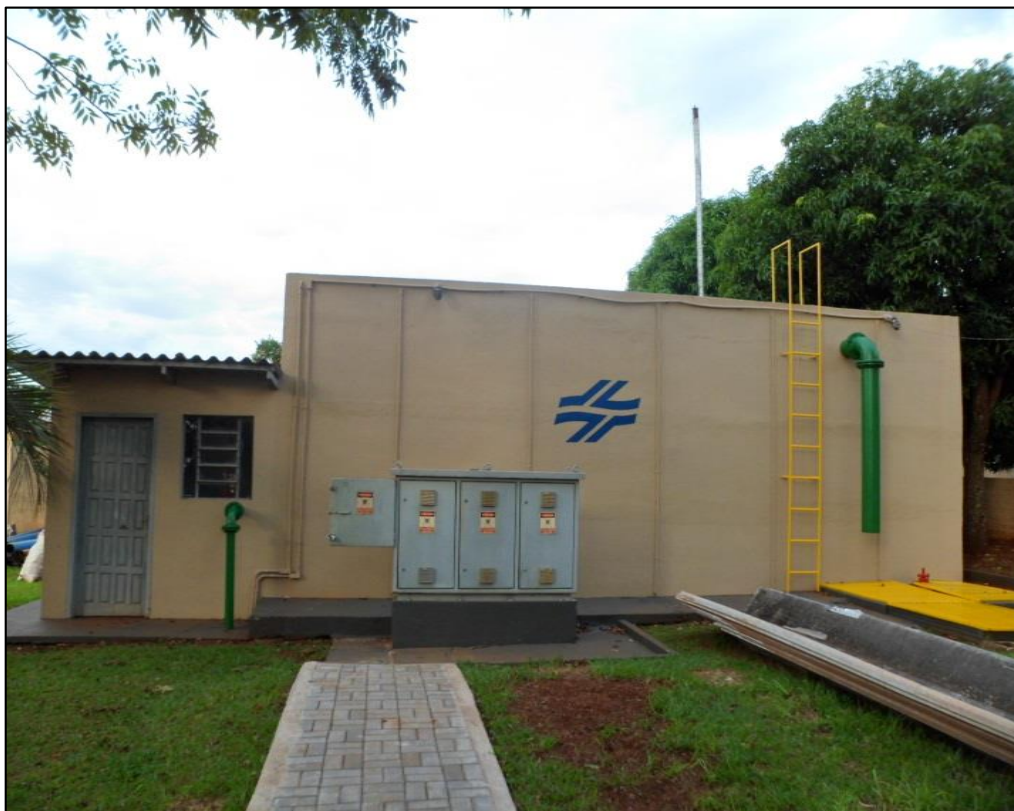
Figura 87: Reservatório Av. Iguaçu, 641 - sede urbana.
