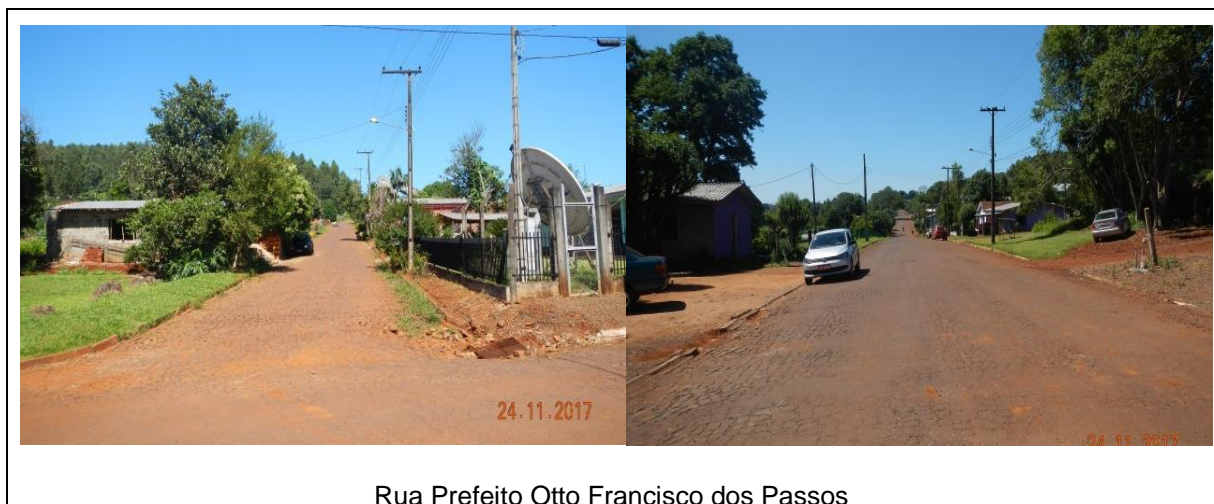
Figura 59: Pavimentação de ruas no Distrito de Bom Jesus.
