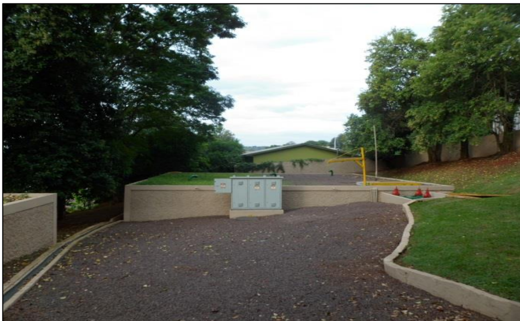
Figura 89: Reservatório Av. Iguaçu, 341.
