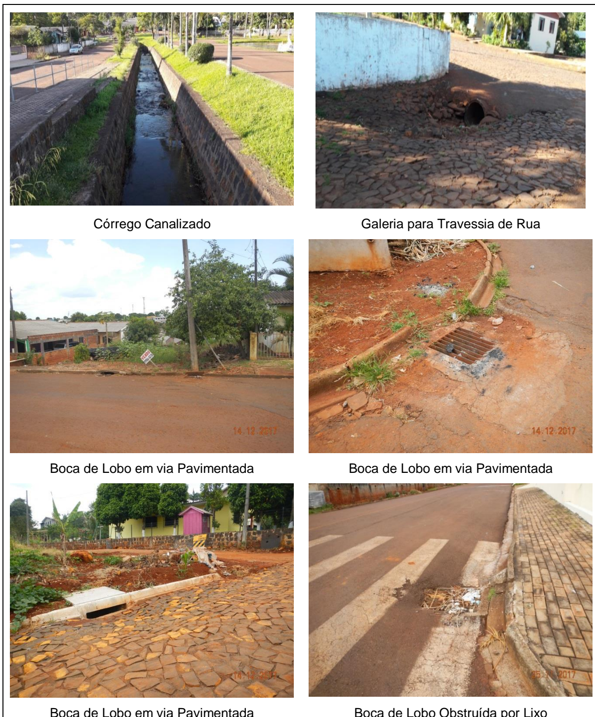
Figura 146: Principais tipologias de unidades operacionais implantadas em Capitão Leônidas Marques para o sistema de drenagem urbana.
