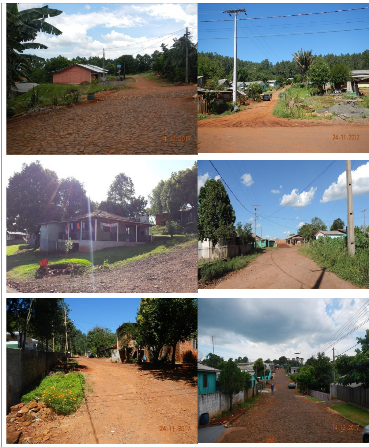
Figura 48: Edificações das áreas periféricas das sedes urbanas no município de Capitão Leônidas Marques.
