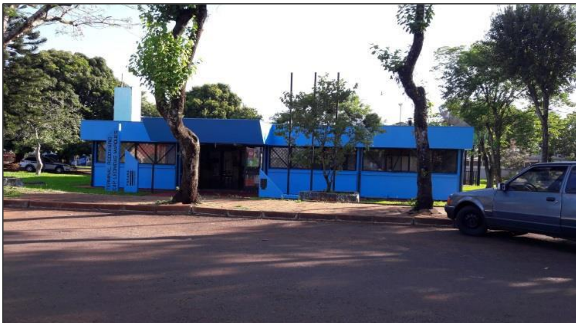
Figura 68: Rodoviária de Capitão Leônidas Marques.
