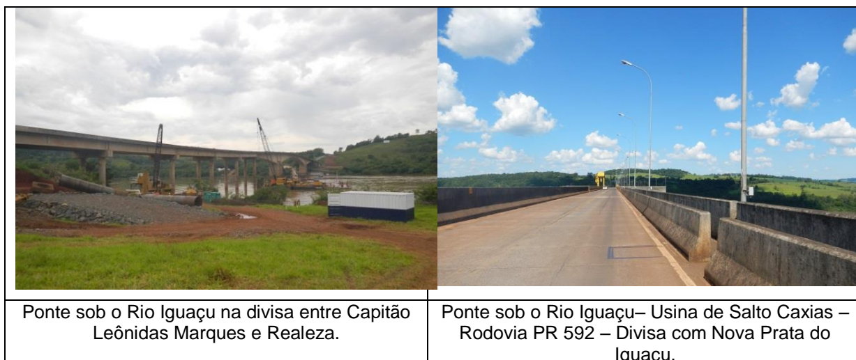
Figura 64: Pontes situadas no município de Capitão Leônidas Marques.
