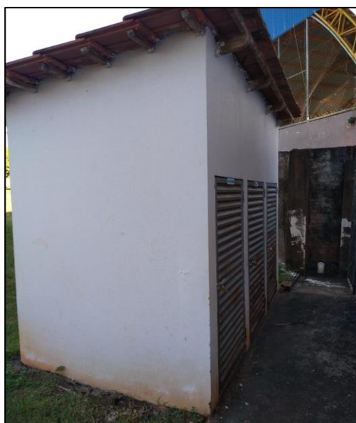
Figura 130: Local externo utilizado para armazenamento dos RSS, até a coleta.
