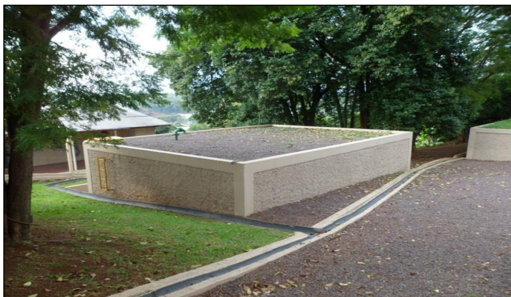
Figura 88: Reservatório Av. Iguaçu, 341 - sede urbana.
