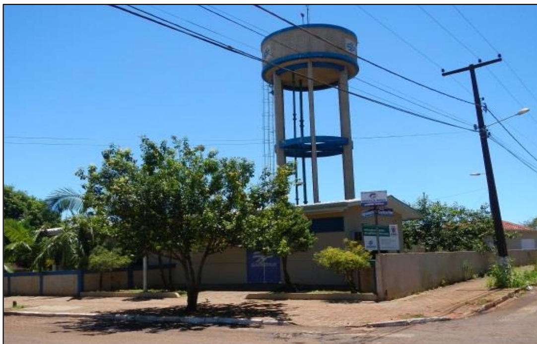
Figura 86: Reservatório Av. Iguaçu, 641 - sede urbana.
