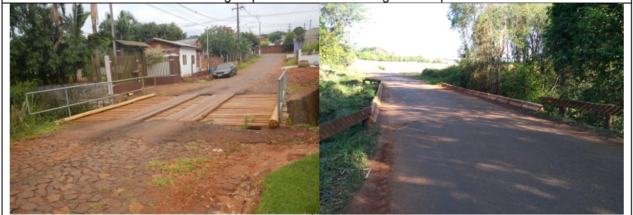
Ponte sob o córrego Aparecida na rua Guarapá
