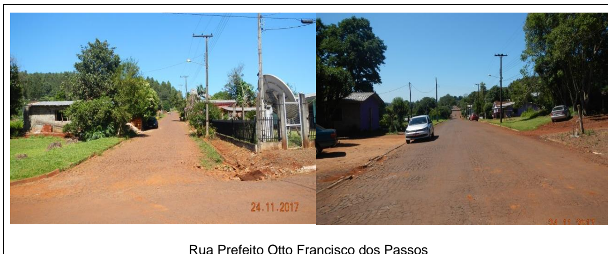
Figura 59: Pavimentação de ruas no Distrito de Bom Jesus.
