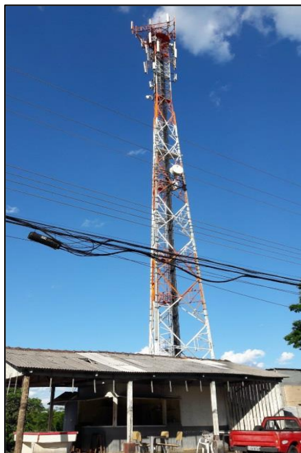
Figura 76: Torre de Telefonia.
